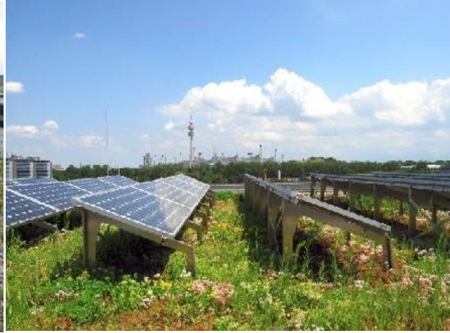
Energiedak, Dubbeldoeldak architectura.be
