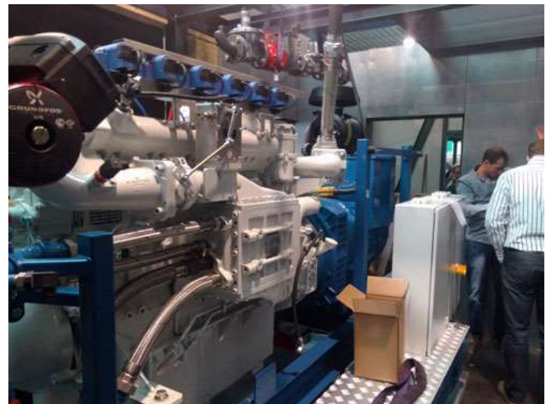
Biogasmotor rwzi-Leiden-Noord
